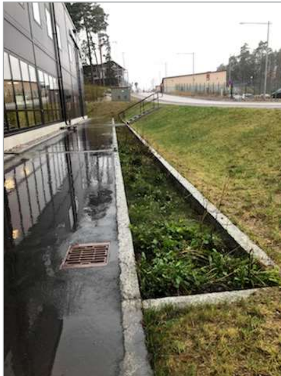
Figur 13. Takdagvatten avleds till regnbädd (foto: Norconsult).
