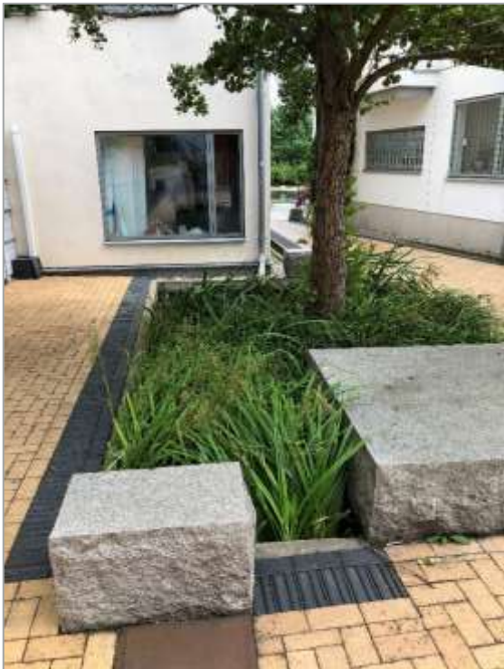
Figur 12. Behandling av dagvatten i regnbädd i Malmö (foto: Norconsult).
