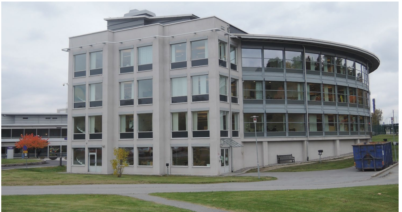
Figur 6. Kontorsbyggnad inom fastigheten Älsunda 7:8.
